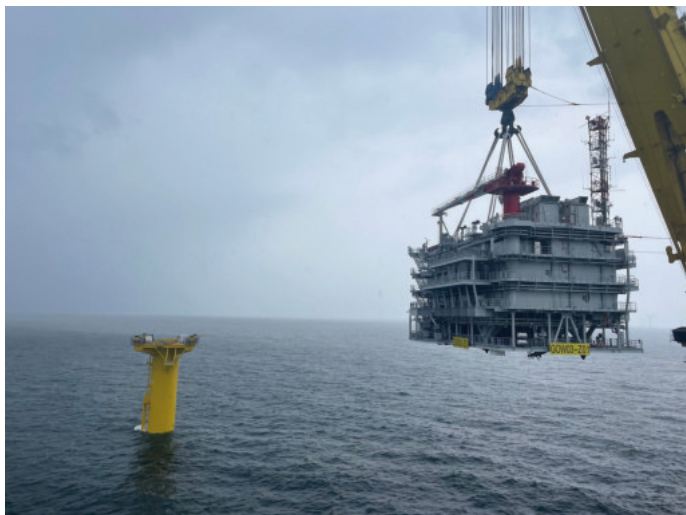
Die Umspannstation wird auf das Fundament gesetzt. Foto: Ørsted
