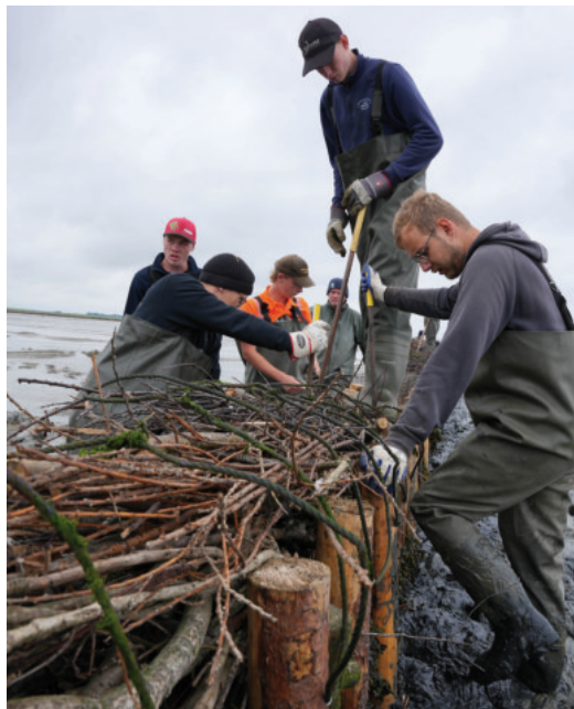
Teamarbeit unter erschwerten Bedingungen: Beim Bau und der Instandsetzung von Buschlammungen muss nicht nur jeder Handgriff, sondern auch jeder Schritt sitzen. Foto: Lippe/NLWKN
