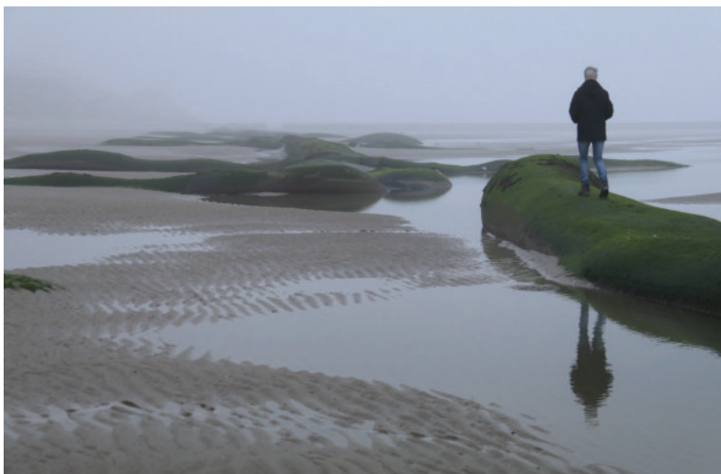
Auch Norderney bleibt von Extremwetterereignissen nicht verschont. Hier an der Kugelbake sind die Sandschläuche, die der Befestigung des Ufers dienen sollen, einmal mehr freigespült worden. Foto: Noun
