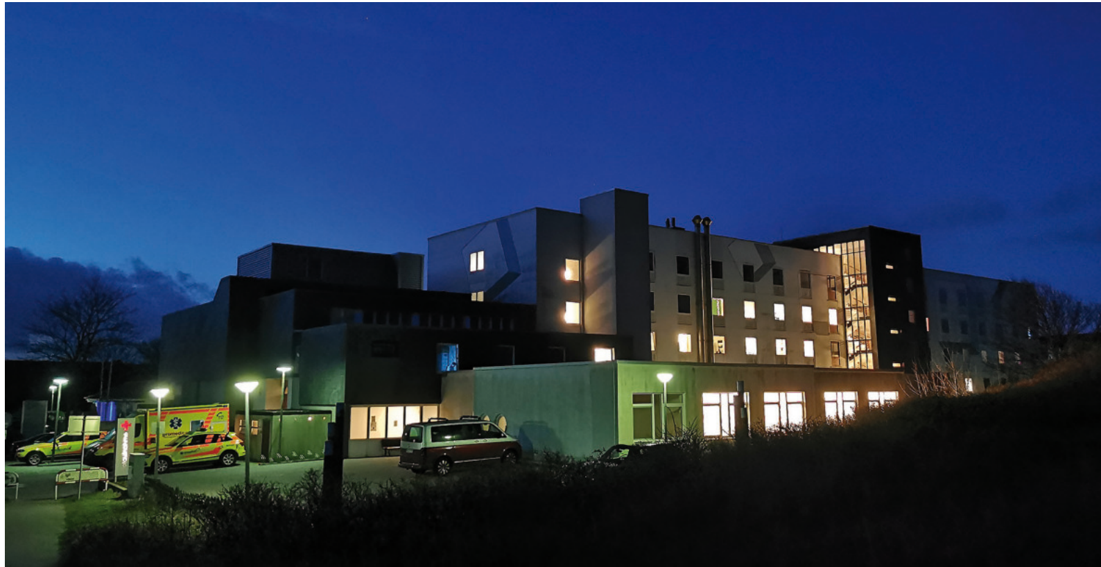
Alles wird getan, damit die Lichter nicht ausgehen. Das Norderneyer Krankenhaus mit Rettungsambulanz bei Nacht.
